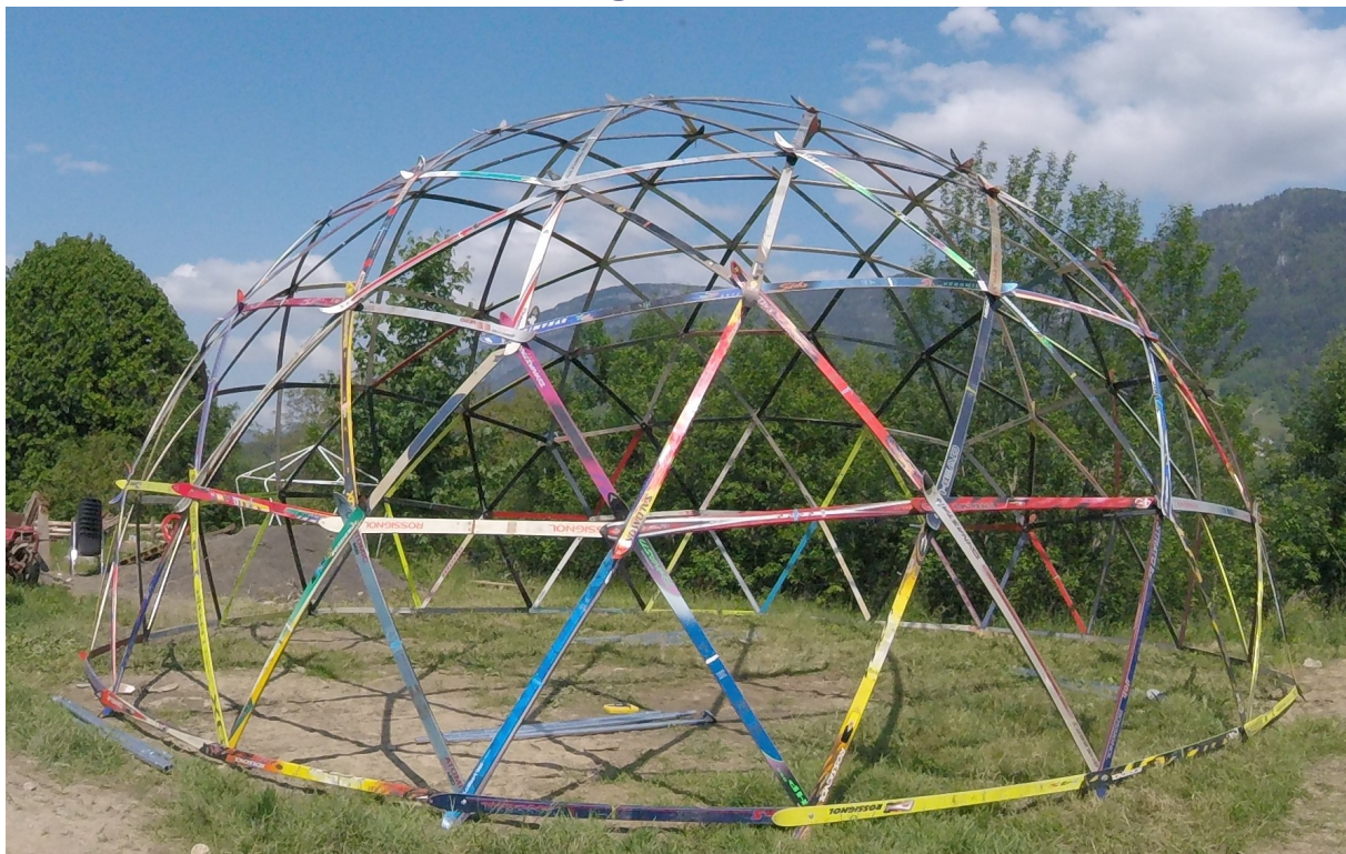
Dôme géodésique fréquence 4 de 10,5m diamètre. (250 skis alpin)
